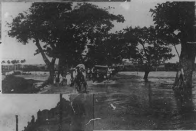
Un tramo de la carretera de la Habana a Güines que fué cubierto por las aguas, dificultando mucho el tránsito por dicha vía de comunicación.
